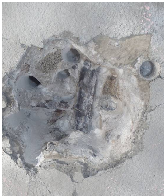
Obr. 71 Vystuženie nosnej konštrukcie
