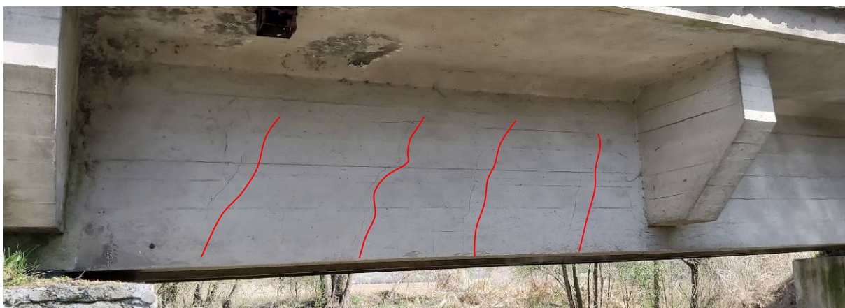
Obr. 45 Trhliny v trámoch a priechnikoch
