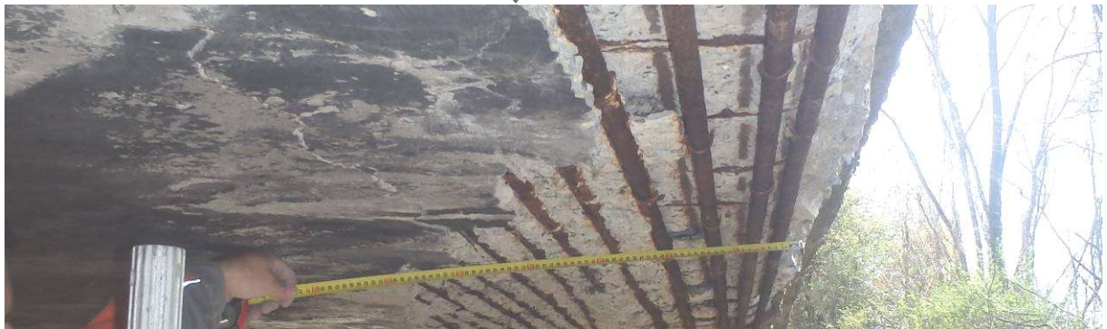
Obr. 10 Vystuženie nosnej konštrukcie v strednom poli
