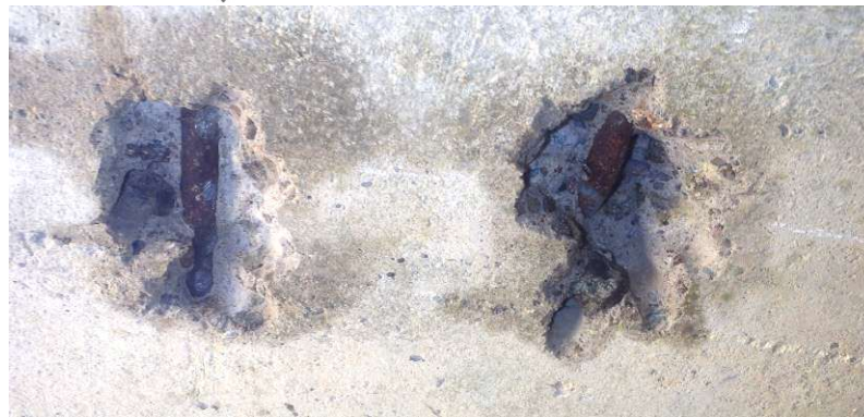
Obr. 28 Vystuženie nosnej konštrukcie
