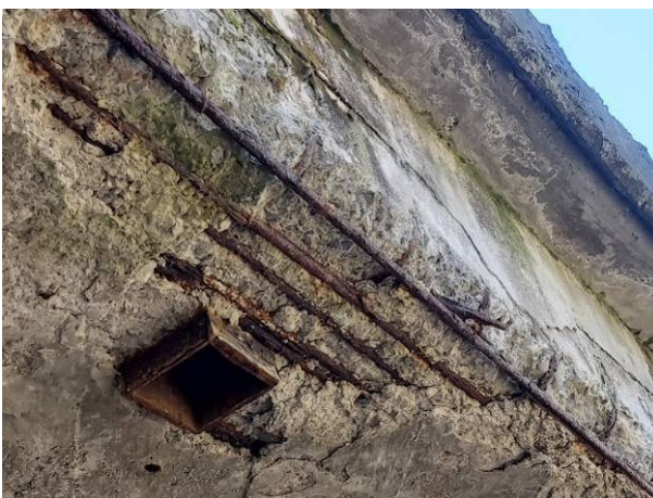
Obr. 13 Korózia výstuže
