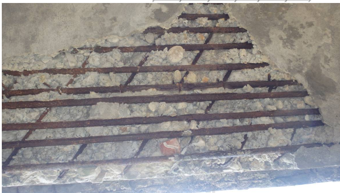
Obr. 77 Vystuženie nosnej konštrukcie
