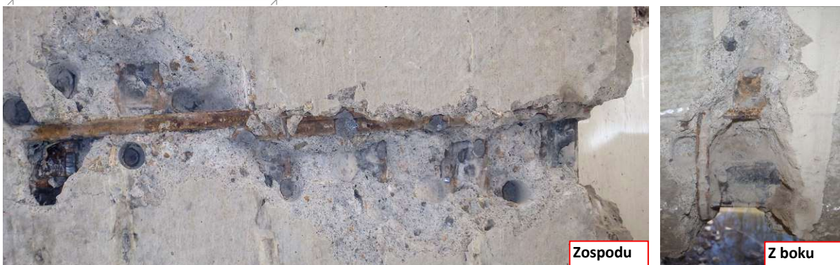
Obr. 41 Vystuženie trámu v strede rozpätia
