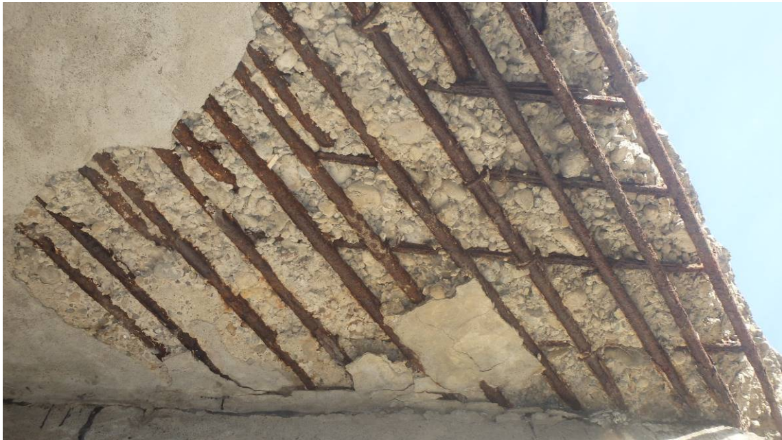
Obr. 78 Vystuženie nosnej konštrukcie pri opore Babina
